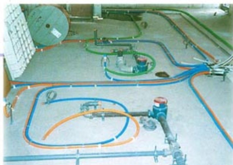
●集合住宅施工例
