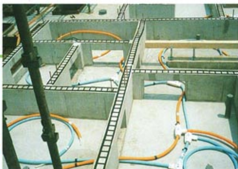
●戸建住宅施工例
